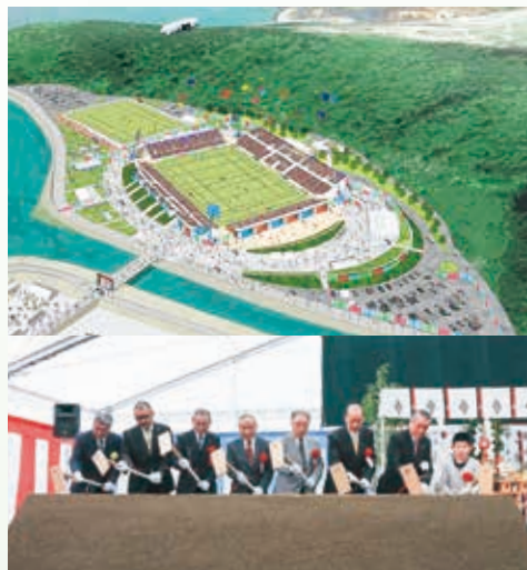
スタジアムの整備工事に着工。釜石開催に向けて大きく前進しました
