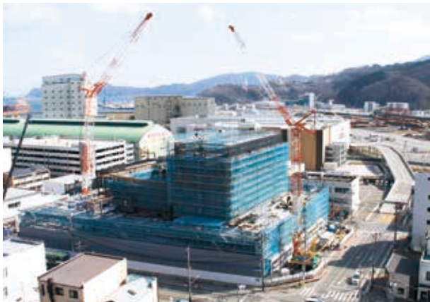
建設が進む釜石市民ホール
