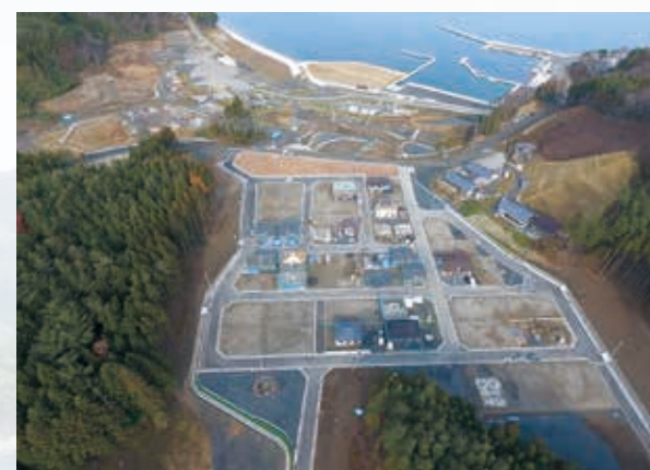
宅地の造成工事が完了した根浜地区
