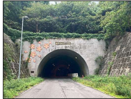
写真 1.2 唐丹さくらトンネル
