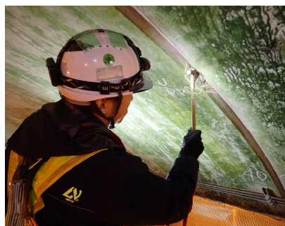
写真 3.2 応急措置(コンクリートうきの叩き落し)
