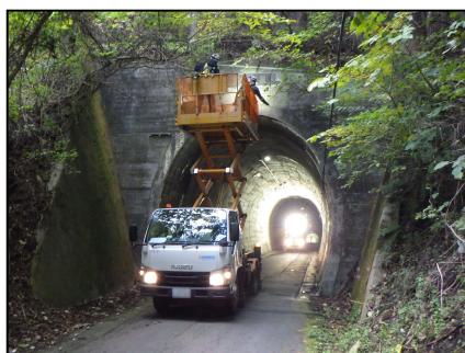
写真 3.1 高所作業車による近接目視
