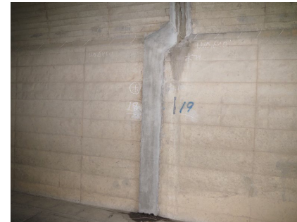
(対策後)導水工(溝切工)
