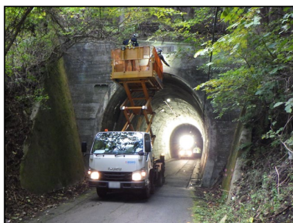
写真 3.1 高所作業車による近接目視
