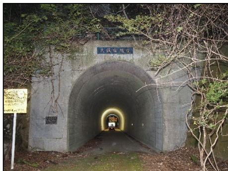
写真 1.1 大坂宿トンネル
