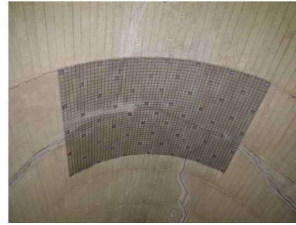
(対策後)ひび割れ注入工+ネット工
