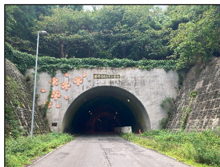
写真 1.2 唐丹さくらトンネル
