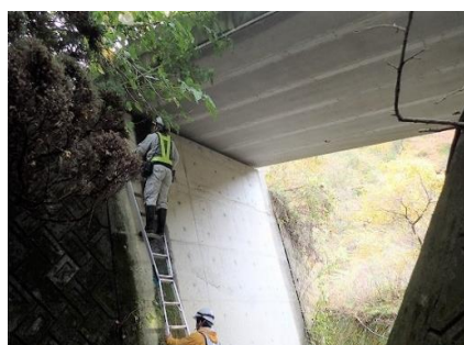
参考写真：点検作業
