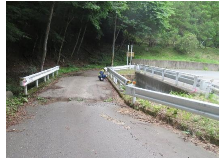
隣接橋に集約可能な橋梁
