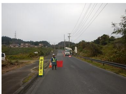
誘導員配置・規制状況
