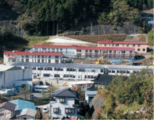
建設が進む唐丹小中学校
