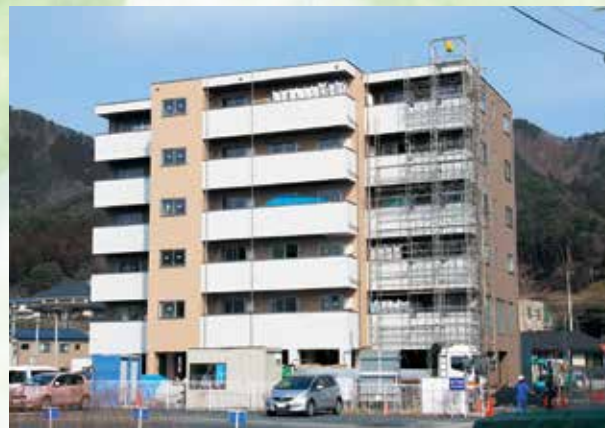
建設工が進む復興公営住宅（只越3号）
