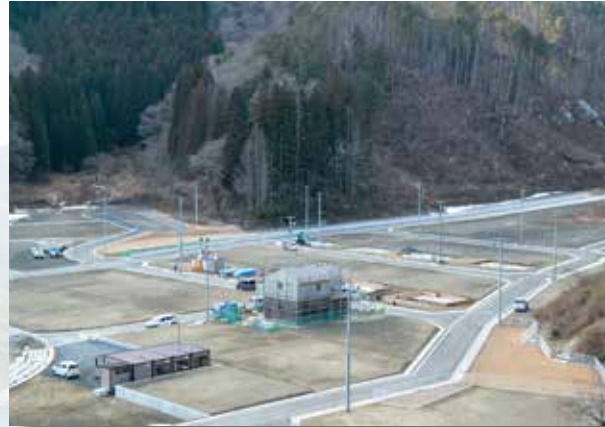
宅地の造成工事が完了した室浜地区
