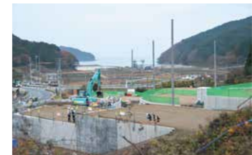
造成工事が進む高台移転地
