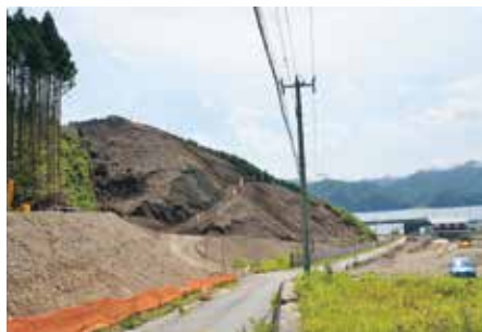
造成工事が進む桑ノ浜地区
