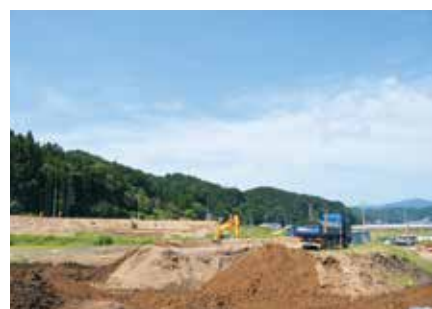
造成工事が進む箱崎地区
