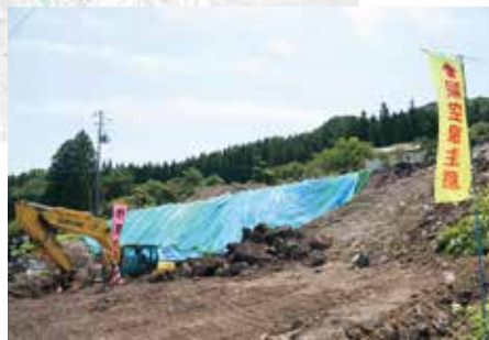
造成工事が進む箱崎白浜地区
