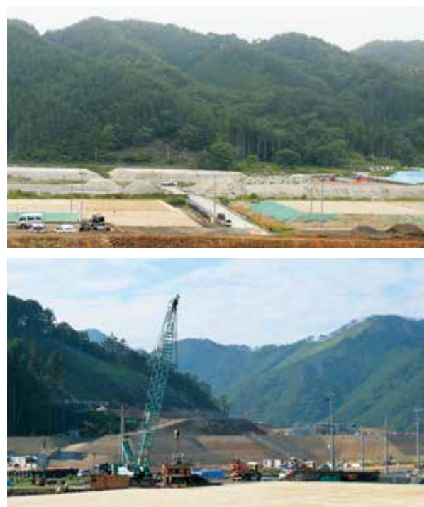
上：現在の鵜住居地区 下：造成工事が進む学校建設予定地
