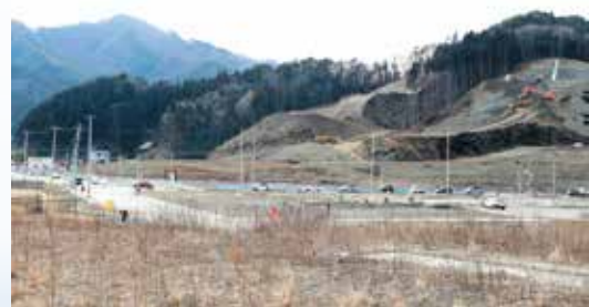
平成29年春の開校に向け造成工事中の鶴住居小・釜石東中建設予定地（鶴住居町）
