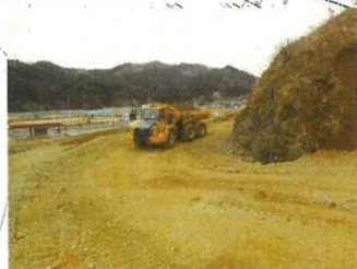
●掘削土運搬状況
