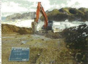
●掘削状況(岩破碎)
