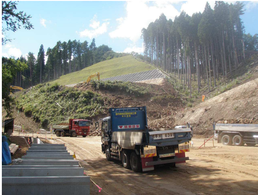
三陸沿岸道路工事(小澤組) 工期平成26年12月26日
