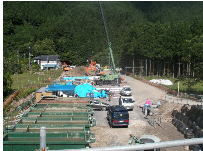
三陸沿岸道路工事(大林組) 工期平成28年8月29日 進捗率 約15%
