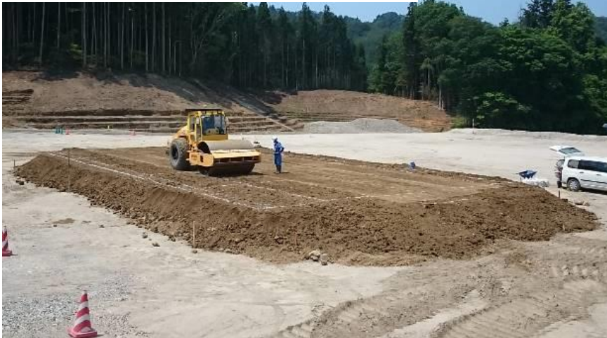
試験盛土による施工方法の決定
