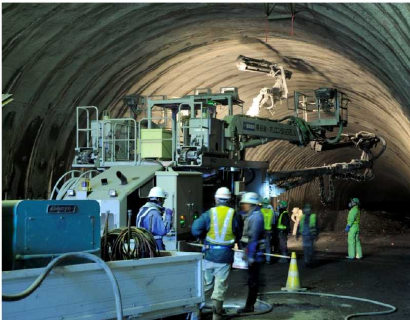
国道45号釜石山田地区道路工事（八雲第2トンネル L=839m） トンネル掘削状況 H25年4月現在(380mまで掘削)
