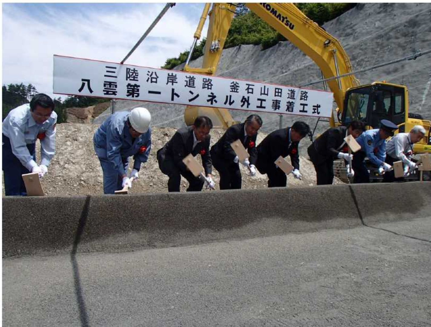
八雲第一トンネル外工事着工式 H24.6.29
