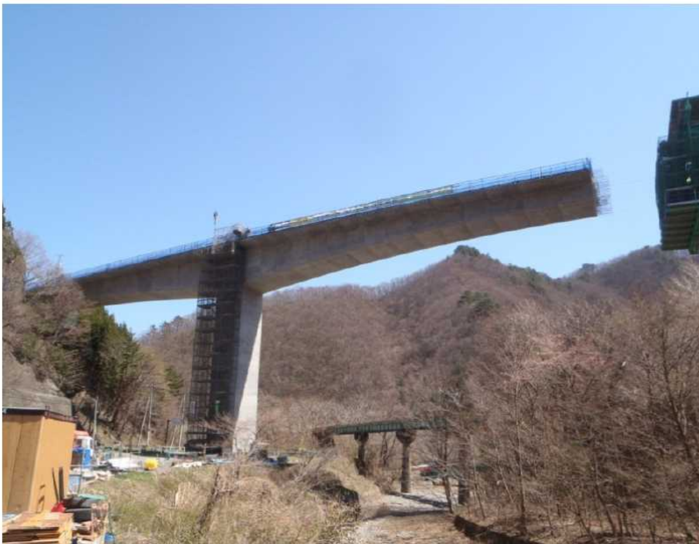
国道45号釜石山田地区道路工事(水海高架橋 L=184m) 上部工施工状況 H25年4月現在(7月閉合予定)
