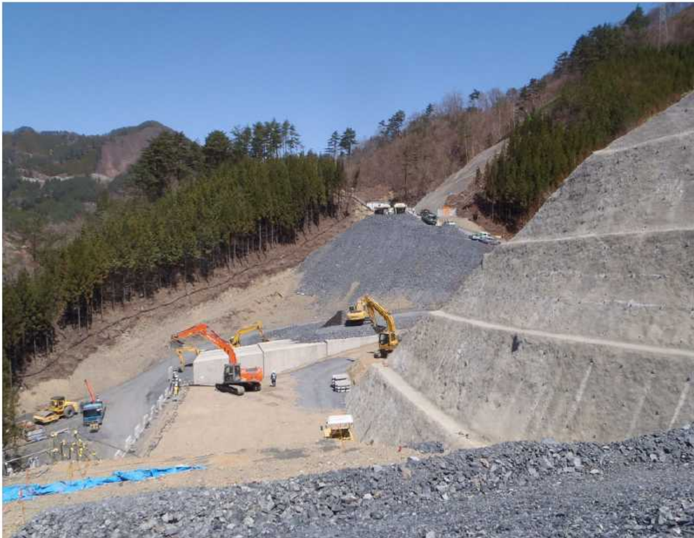
国道45号釜石山田地区道路工事(両石地区) 切土施工状況 H25年4月現在
