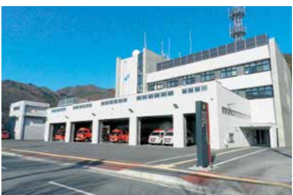
平成25年度に完成した釜石消防署庁舎（鈴子町）
