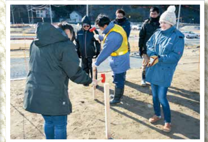
敷固めた土に杭を打ち込み、宅地強度を確認
