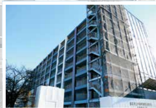
建設が進む上中島町復興公営住宅Ⅱ期
