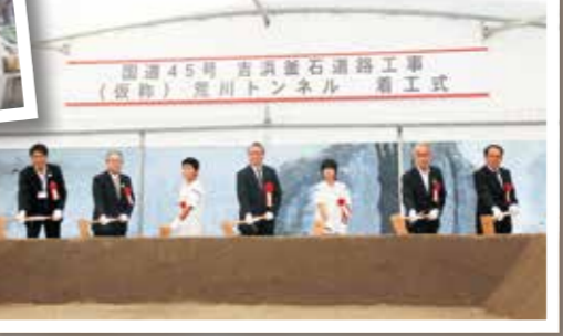
9月9日 ▶ 吉浜釜石道路荒川トンネル着工 2016年1月の貫通、同年8月の完成を目指し、唐丹町片岸のトンネル北側坑口で関係者がくわ入れを行い、工事の安全を祈りました。
