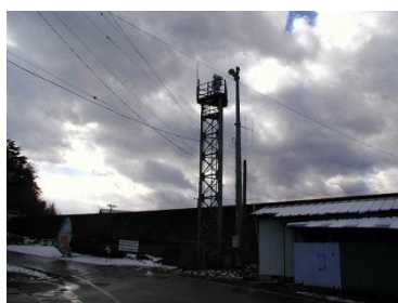
【写真-09】 津波監視カメラ
