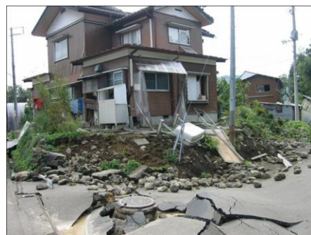
【写真-06】 2004年新潟県中越地震による被害
