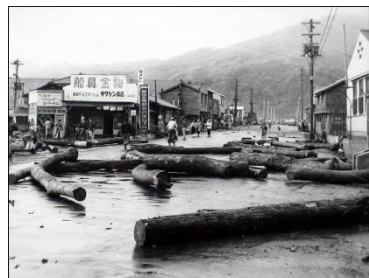
【写真-03】1960年 チリ地震津波による釜石市の被害
