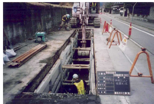
一般的な開削工法による管の布設状況
