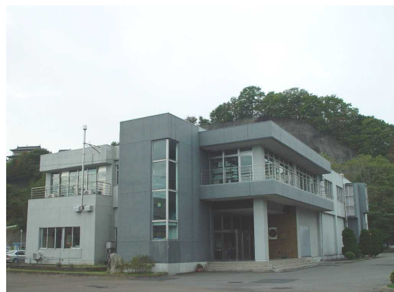
大平下水処理センター管理本館
