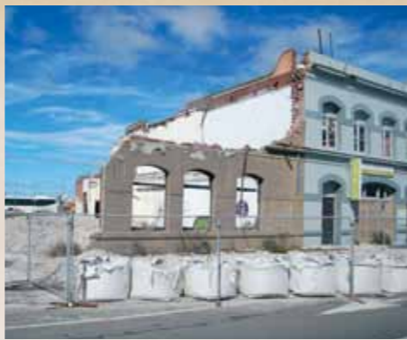
クライストチャーチ市内にある地震で倒壊した建物
