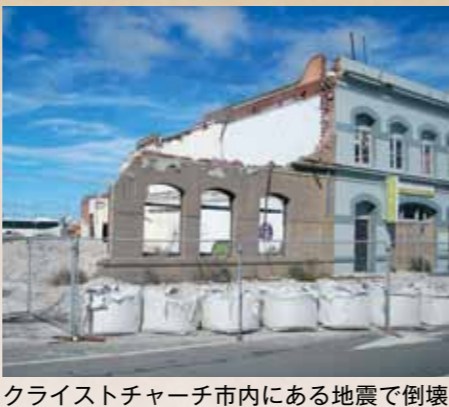
クライストチャーチ市内にある地震で倒壊した建物
