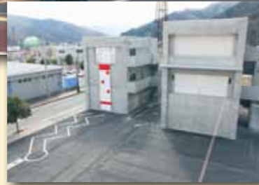
2棟の多目的資材倉庫
