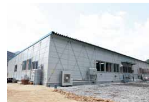
完成した鵜住居幼稚園仮設園舎
