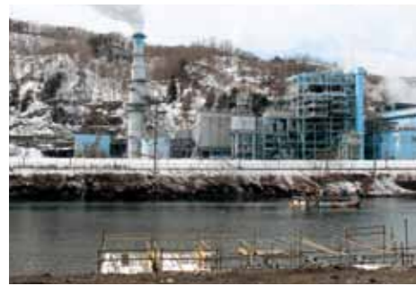
甲子川に橋を新設し、中番庫地区(手前)と国道283号(対岸)を接続
