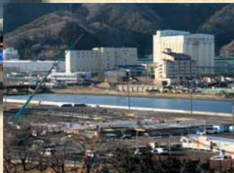
釜石警察署跡地に建設が進む水産物流センター
