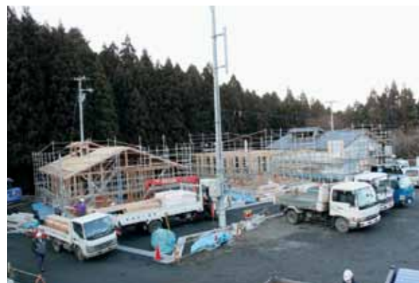
3月完成に向けて工事が進む箱崎白浜復興公営住宅(戸建)
