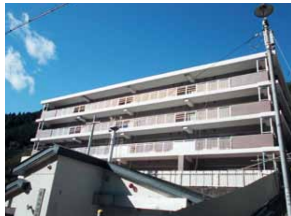
25年12月に完成・入居となった花露辺復興公営住宅(集合)
