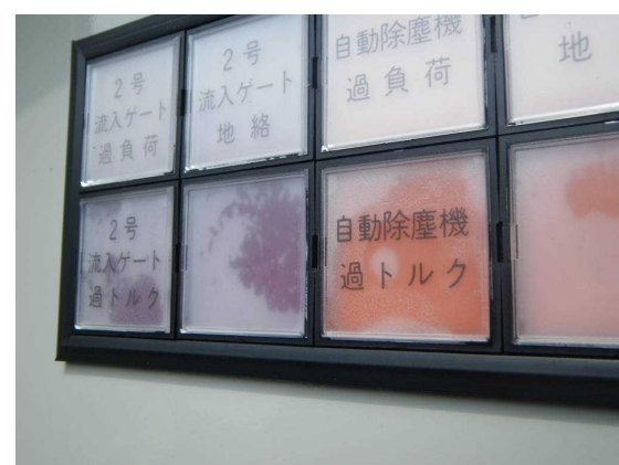
屋外現場操作盤の浸水した部分
