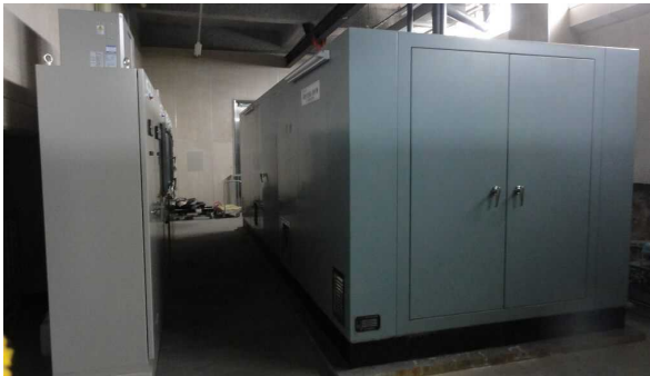
汚泥棟 2階の設備等は無事 脱水機設備
