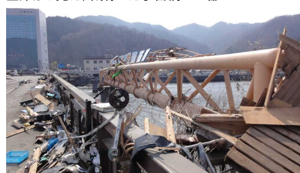
左岸から見た、残存した水管橋の一部
