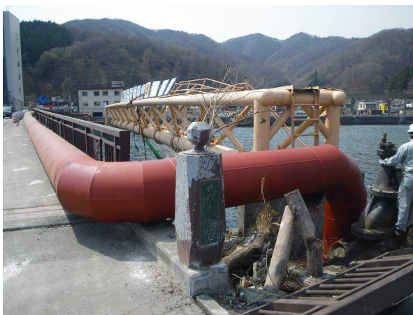
応急仮復旧後の 左岸接合部と 隣接する矢の浦橋歩道部への添上状態
