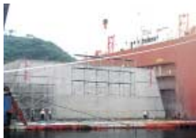
泉作業基地にあるフローティング ドッグでのケーソン製作
