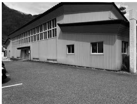
拠点避難所の一つ 双葉小学校体育館
