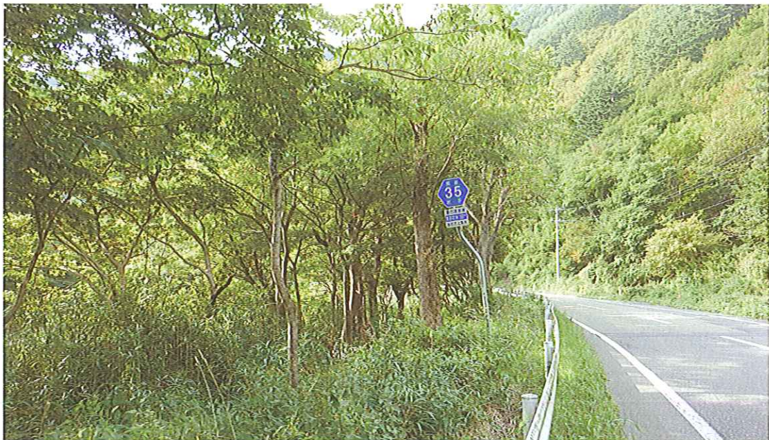
作業前の状況 平成22年10月1日撮影
