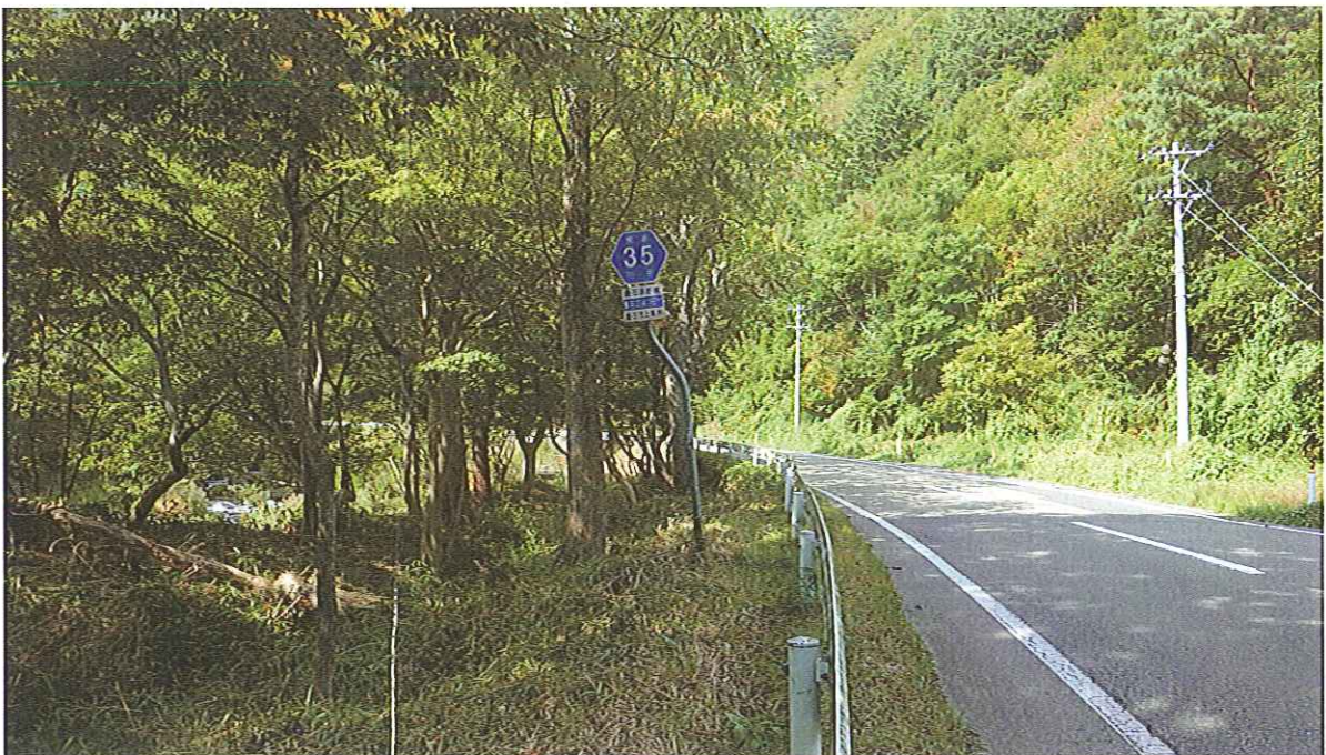
作業後の状況 平成22年10月6日撮影
