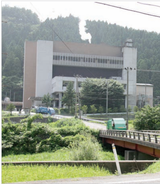
現在稼働中の市清掃工場（栗林町）
