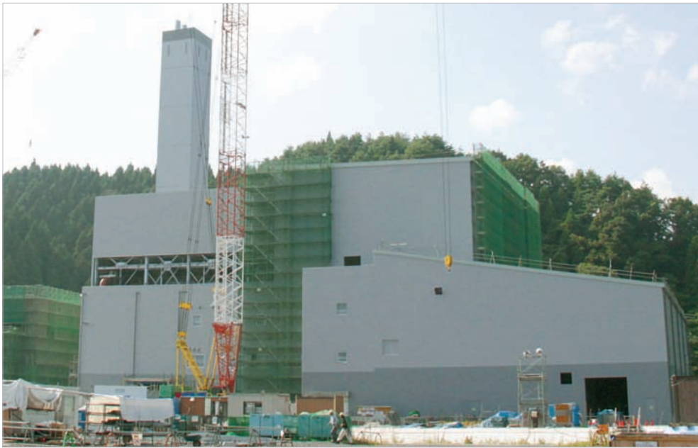
建設が進むクリーンセンター
