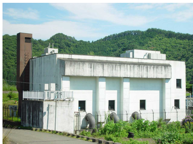
鵜住居雨水排水ポンプ場
