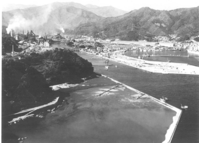
大平工業団地・須賀埠頭埋め立て工事 昭和45年10月ヘリコプターより撮影、港湾修築工事中の写真。 翌46年完成。左端に観光道路が見える。 撮影 丹野 雅史氏
