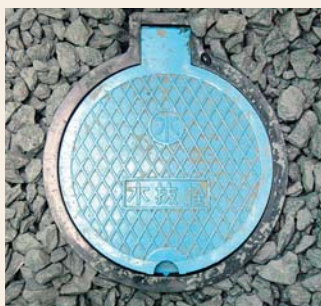
水抜栓(屋外操作型)の一例
