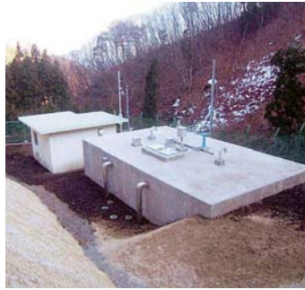
鵜住居上水道統合整備工事
