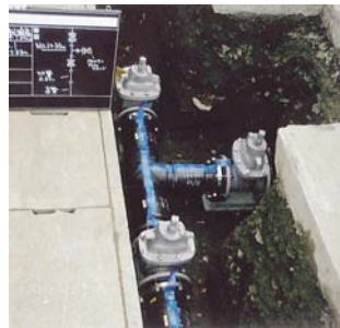
国道283号（砂子渡地区）配水管布設工事
