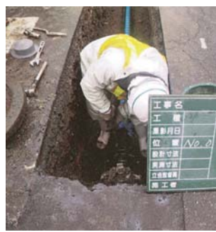
中妻町地区老朽管布設替工事
