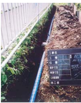
小白浜簡易水道再編推進工事
