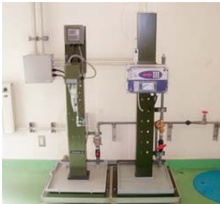
唄貝配水池連続水質監視装置設置工事
