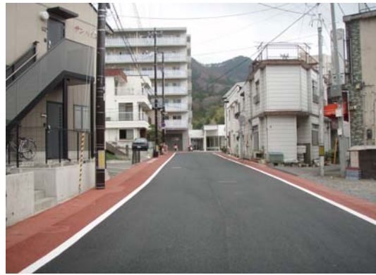
市道大町1号線整備後
