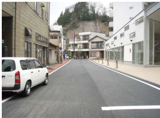
市道大町1号線整備後
