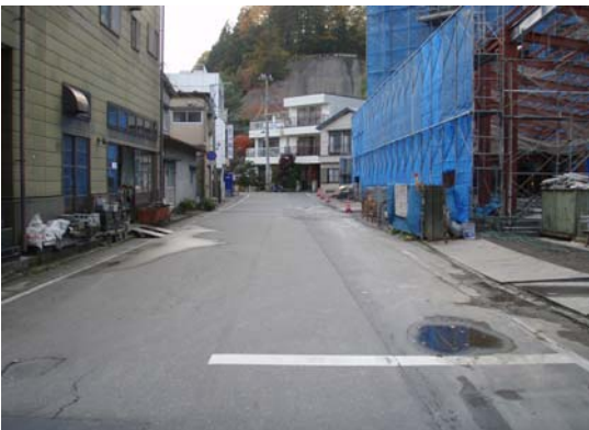
市道大町1号線整備前
