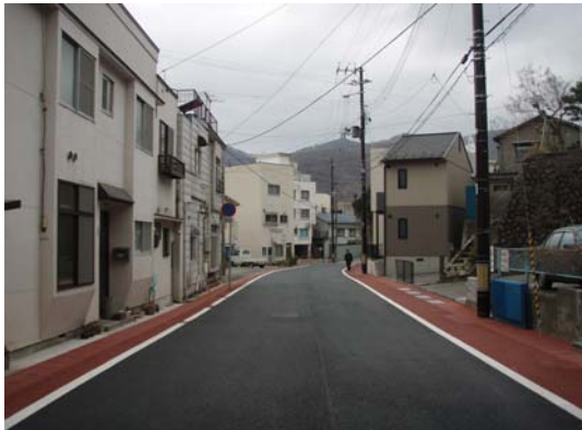
市道大町1号線整備後(電柱移設及び修景含む)
