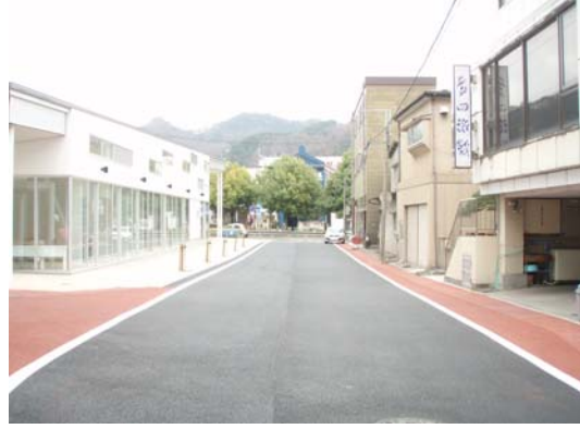
市道大町1号線整備後(路肩のカラー舗装化)
