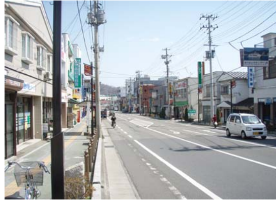
大渡町商店街整備後
