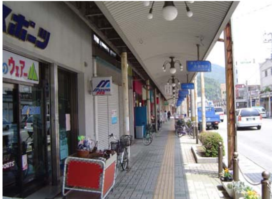
アーケード支柱修景前
