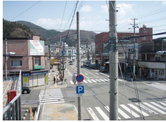
アーケード撤去後
