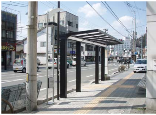
バスシェルター整備、間接照明整備(宝くじ助成事業)
