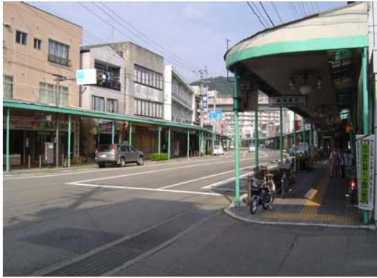
アーケード撤去後(街路灯整備)
