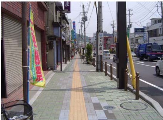
街路灯整備前
