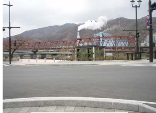
大渡橋橋詰広場整備後
