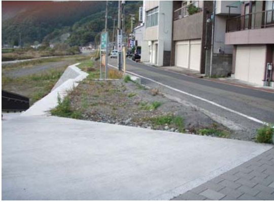
橋詰広場遊歩道整備前
