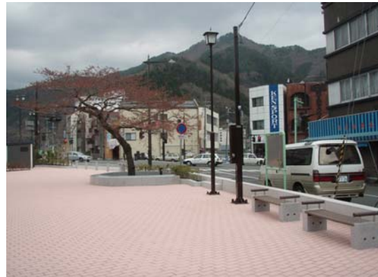
サークルベンチ、照明灯、ベンチ整備
