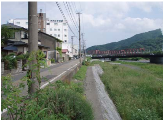
橋詰広場遊歩道整備前
