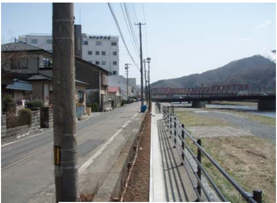
橋詰広場遊歩道整備後
