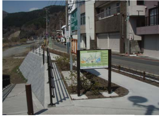
橋詰広場遊歩道整備後
