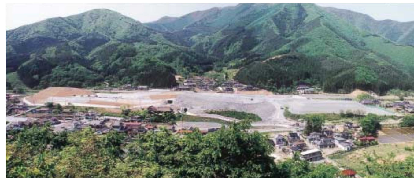
仙人峠道路(仮称)釜石西I.C.予定地
