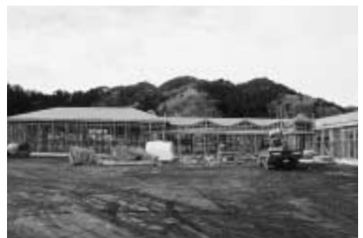
建築工事が進む鶴住居保育園
