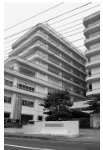
釜石市保健福祉センター
